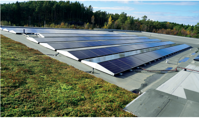
Takarealet, som ikke er dekket av solcellepaneler, er grønt tak.
