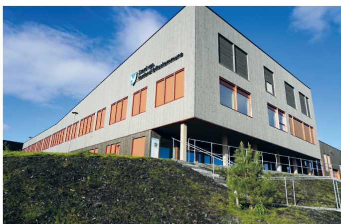
Skolens fasade har fått trekledning, som er impregnerert med en kobberløsning.
