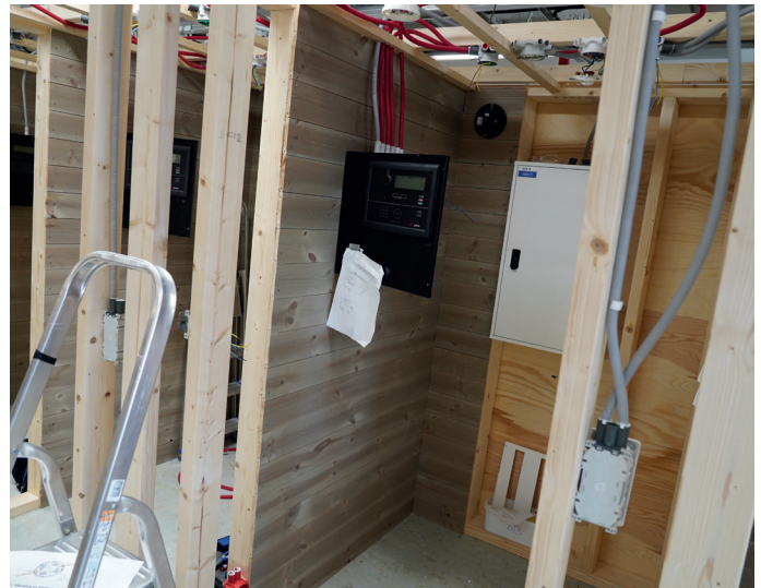
I denne uferdige innredningen skal elever ved elektrolinjen trene på el-installasjon.
